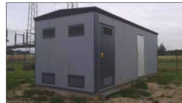
Figur 2.7. Eksempel på udformning af teknikbygning ved transformerstation.
